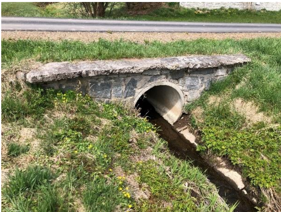
Obrázek 53 Pohled na betonový propustek DN1000 na přítoku (po proudu)
