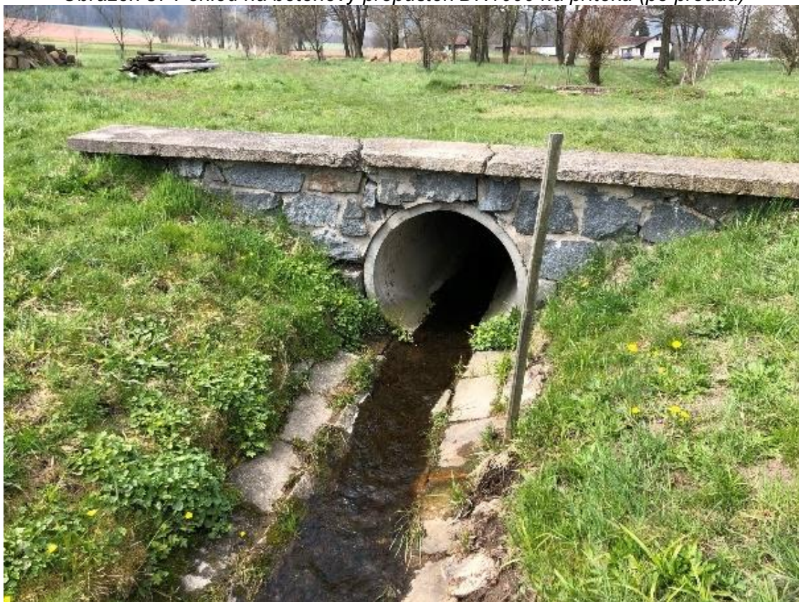
Obrázek 58 Pohled na betonový propustek DN1000 na odtoku (proti proudu)
