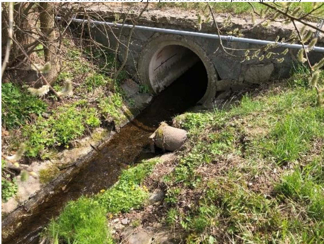
Obrázek 54 Pohled na betonový propustek DN1000 na odtoku (proti proudu)
