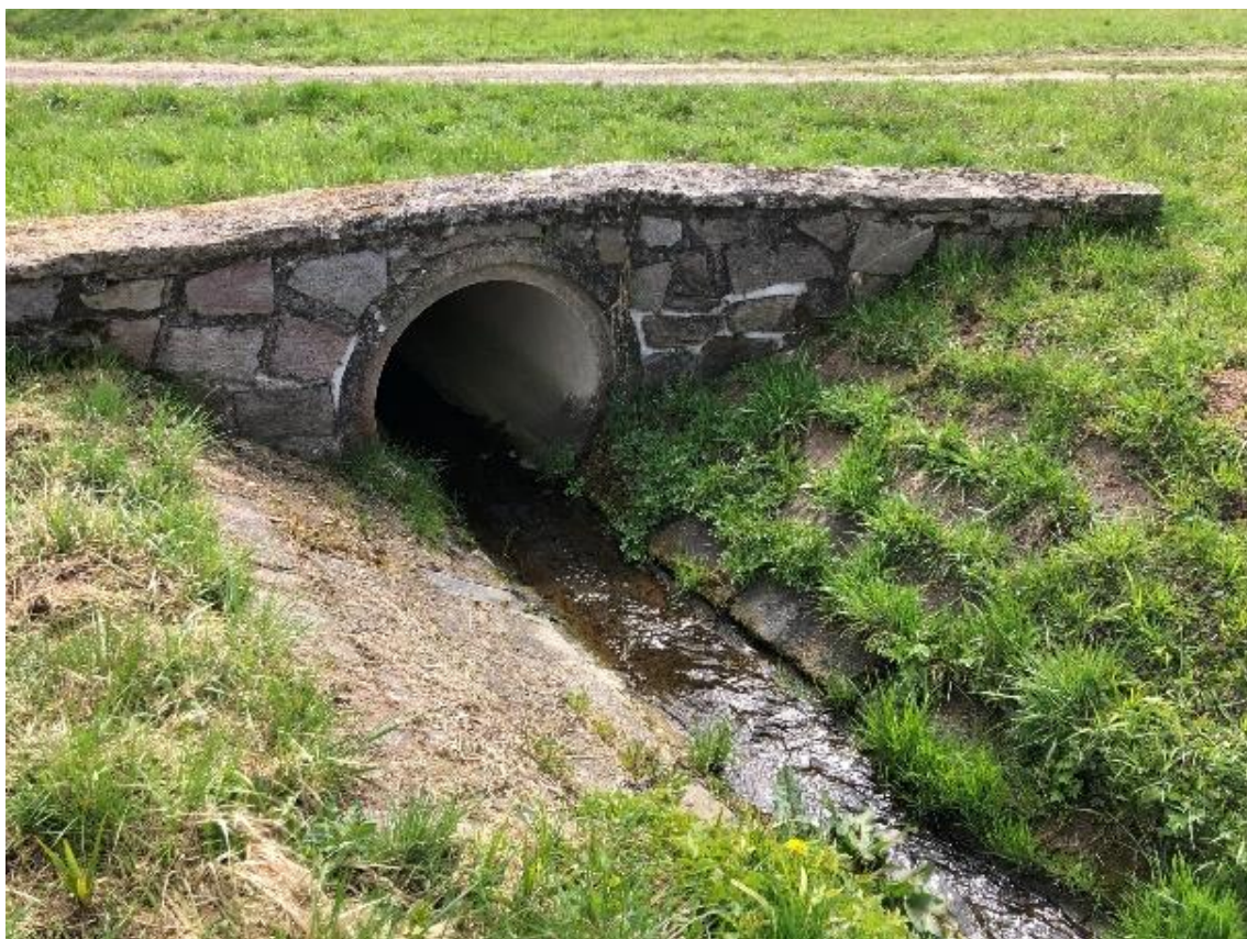
Obrázek 59 Pohled na betonový propustek DN1000 na přítoku (po proudu)
