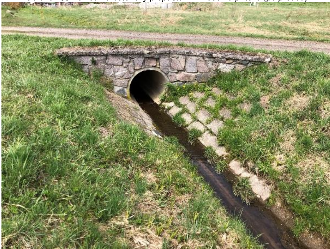
Obrázek 60 Pohled na betonový propustek DN1000 na odtoku (proti proudu)
