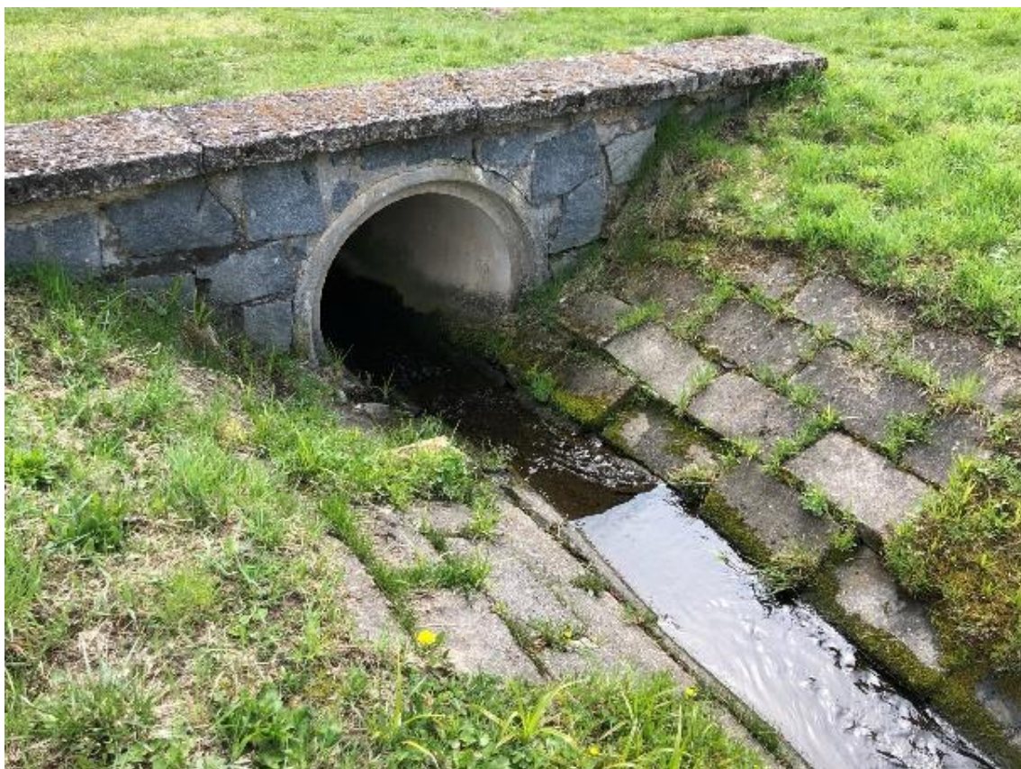
Obrázek 57 Pohled na betonový propustek DN1000 na přítoku (po proudu)
