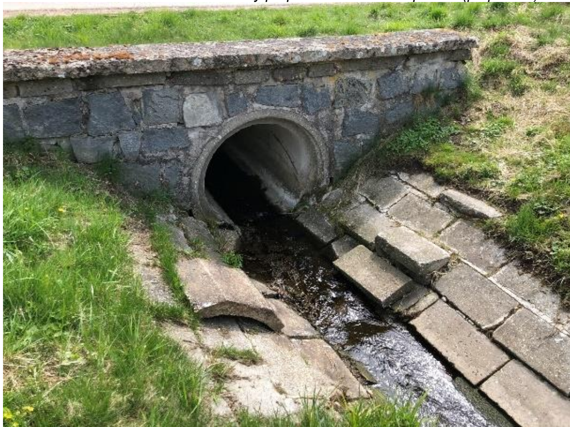
Obrázek 56 Pohled na betonový propustek DN1000 na odtoku (proti proudu)
