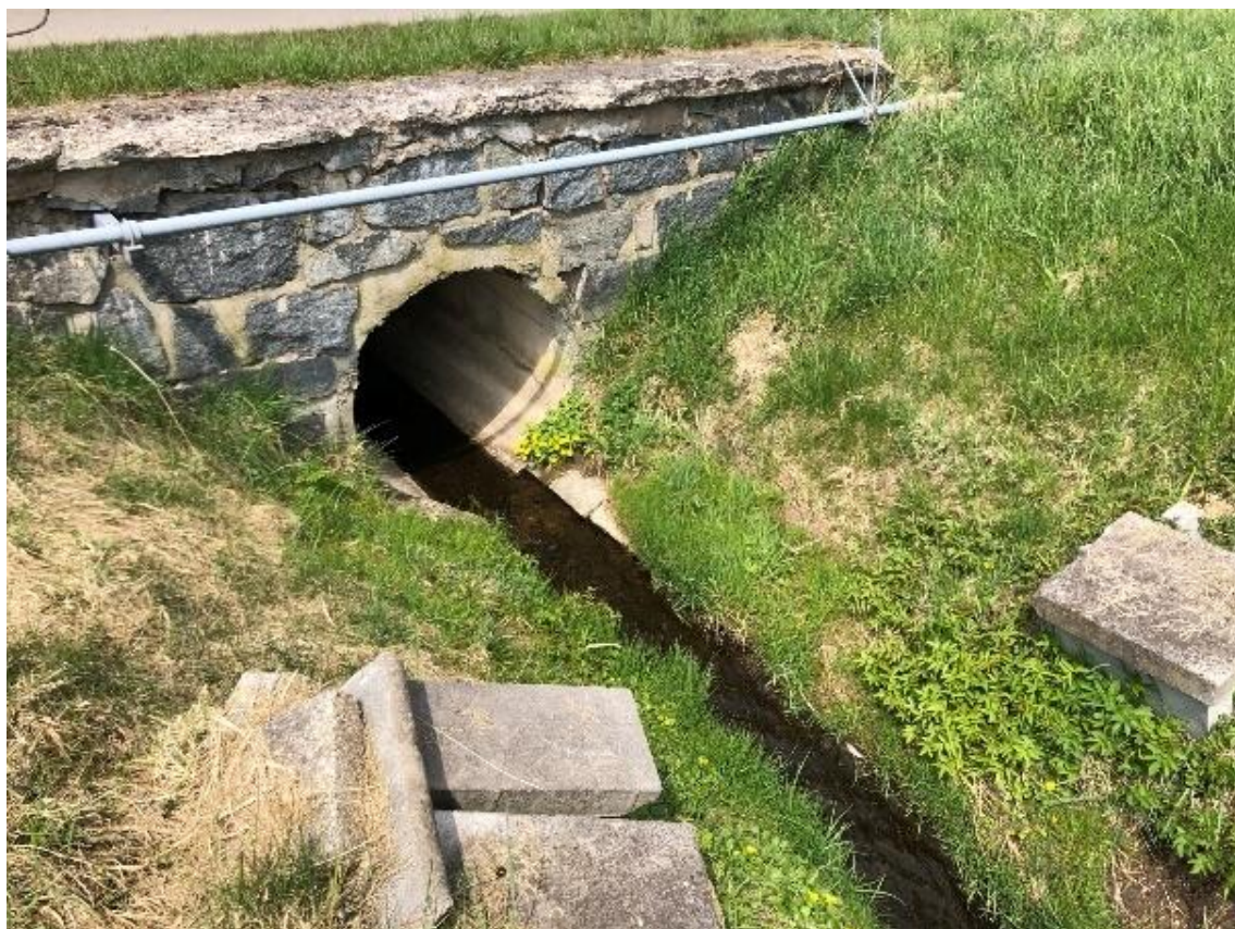
Obrázek 55 Pohled na betonový propustek DN1000 na přítoku (po proudu)
