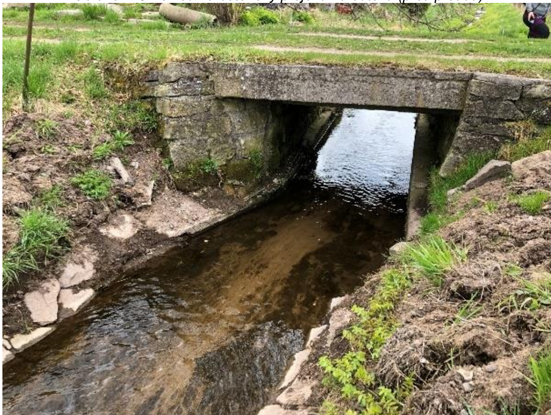
Obrázek 20 Pohled na betonový přejezd na přítoku (po proudu)
