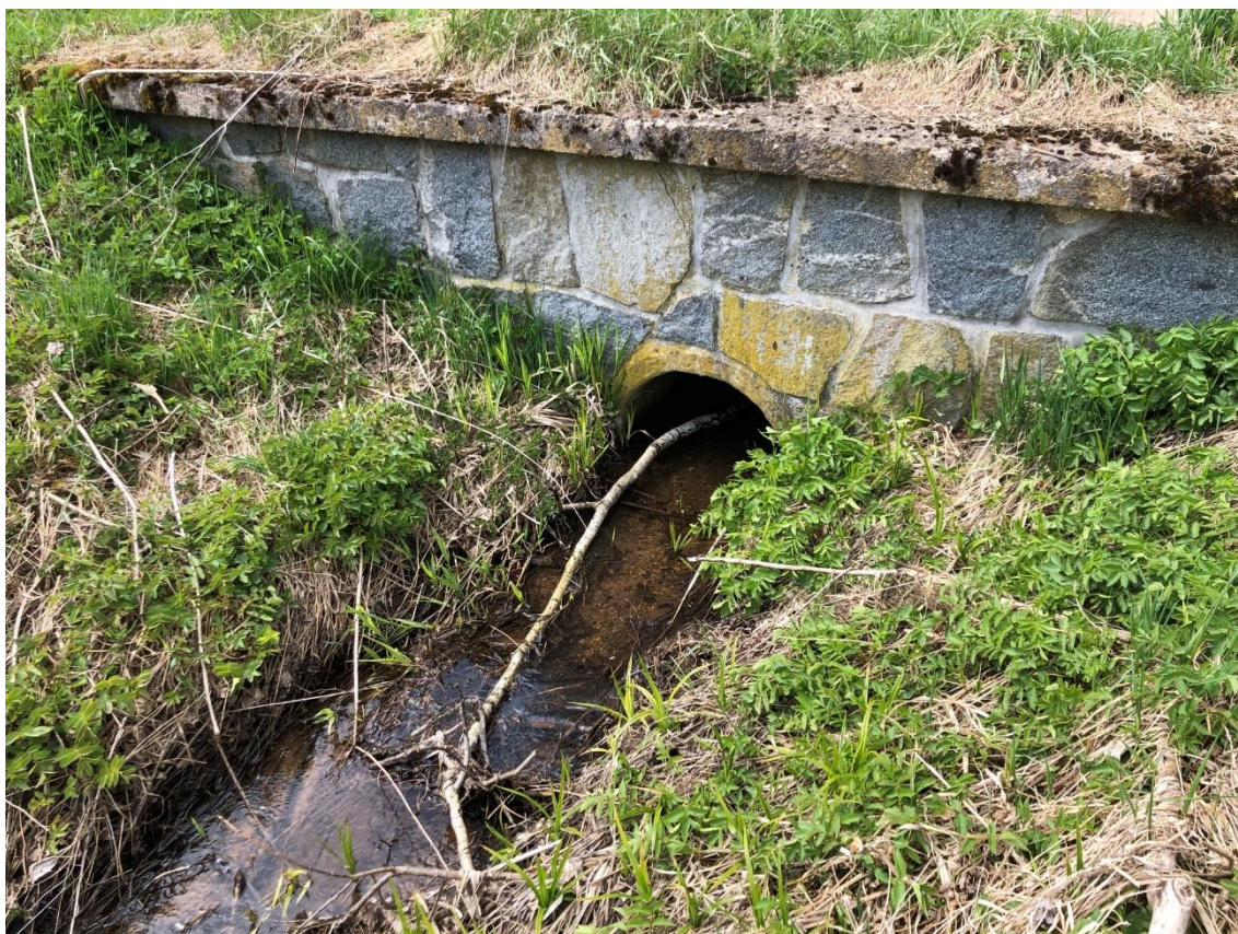
Obrázek 64 Pohled na betonový propustek DN 1000 na odtoku (proti proudu)
