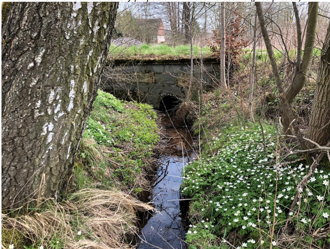
Obrázek 65 Pohled na betonový propustek DN1000 na přítoku (po proudu)
